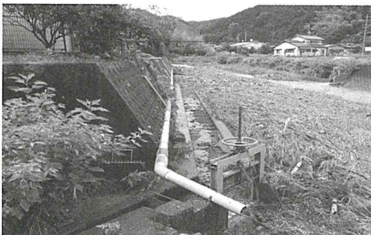
写真C 富士市北松野下平方面市道拡幅工事中現場
